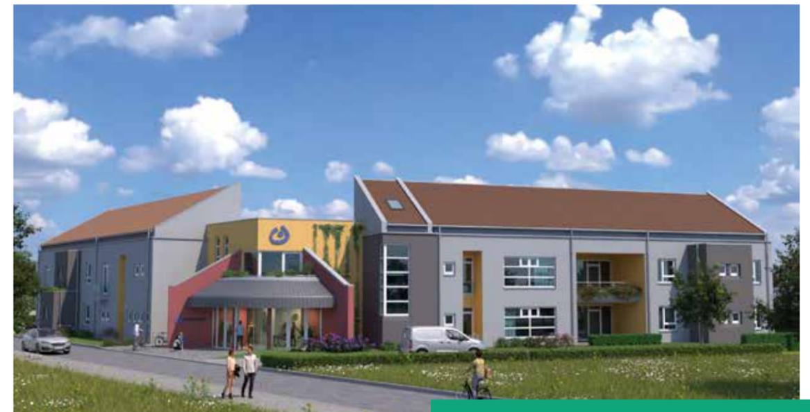
Wir erstellen einen nicht unterkellerten Massivbau mit 36,5 cm starken Wärmedämm- Außenwänden. Alle Geschossdecken werden in Stahlbeton ausgeführt.
